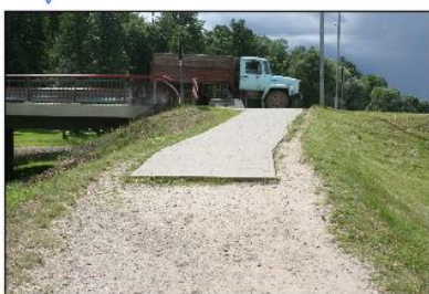
8 Betona bruģakmens seguma celiņš
