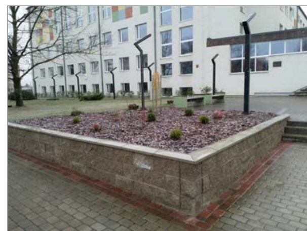
Projekta "Balvu Valsts ģimnāzijas represēto skolotāju un skolēnu piemiņas vietas izveides noslēguma posma īstenošana" ietvaros notika ģimnāzijas priekšpagalma pakāpienu un āra apstādījumu apmales būvju restaurācija un teritorijas labiekārtošana, tādējādi noslēdzot Balvu Valsts ģimnāzijas represēto skolotāju un skolēnu piemiņas vietas izveidi. Šis projekts veicinās vietas potenciālu funkcionalitāti un pievilcību, kā arī stiprinās fiziskā un kultūras kapitāla ilgtspējīgas izmantošanas un attīstības iniciatīvu.
