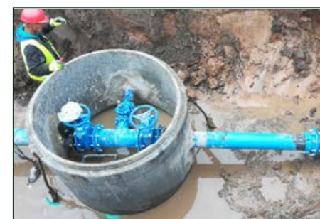
Celtnieku ielas ūdensvada pieslēguma izbūve uz Partizānu ielas.
