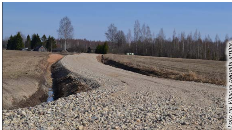
Vīksnas pagasta ceļa Sprogas - Oknupe - Pokuļeva posma pārbūve.
