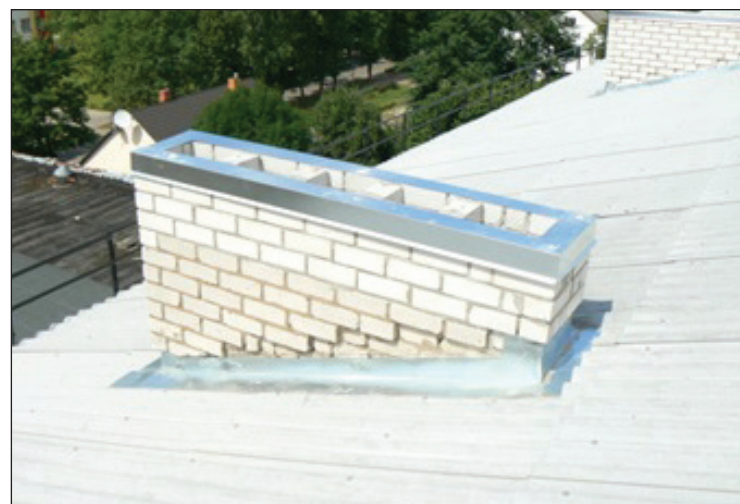
Partizānu iela 21A. Ventilācijas kanālu un jumta seguma izbūve
