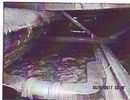
Daļai koka kopņu izzāģēta daļa no apakšējās joslas, atlikušo daļu piesienot pie nesošās sienas ar stiepli
