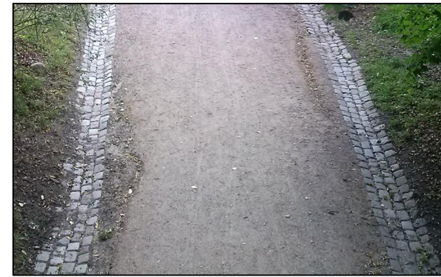
Grants takas pasargāšanai no izskalojumiem, piemērs
