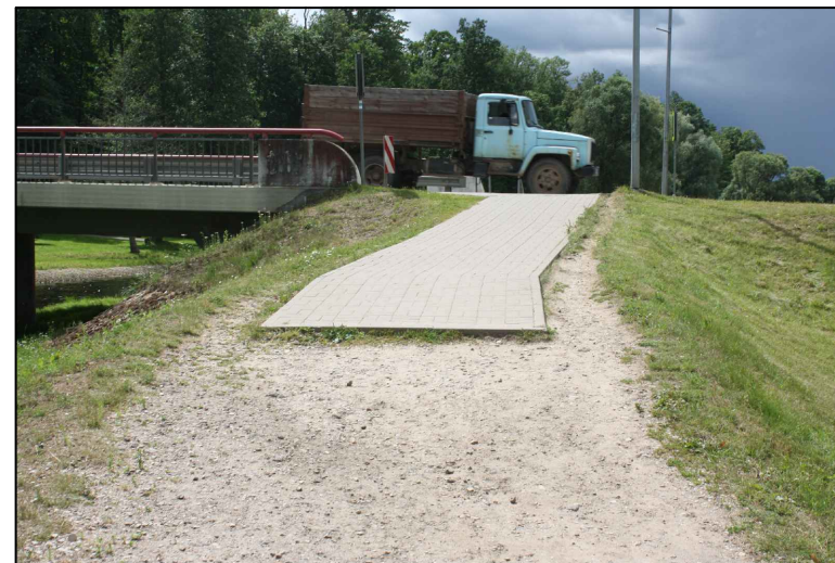
8 Betona bruģakmens seguma celiņš
