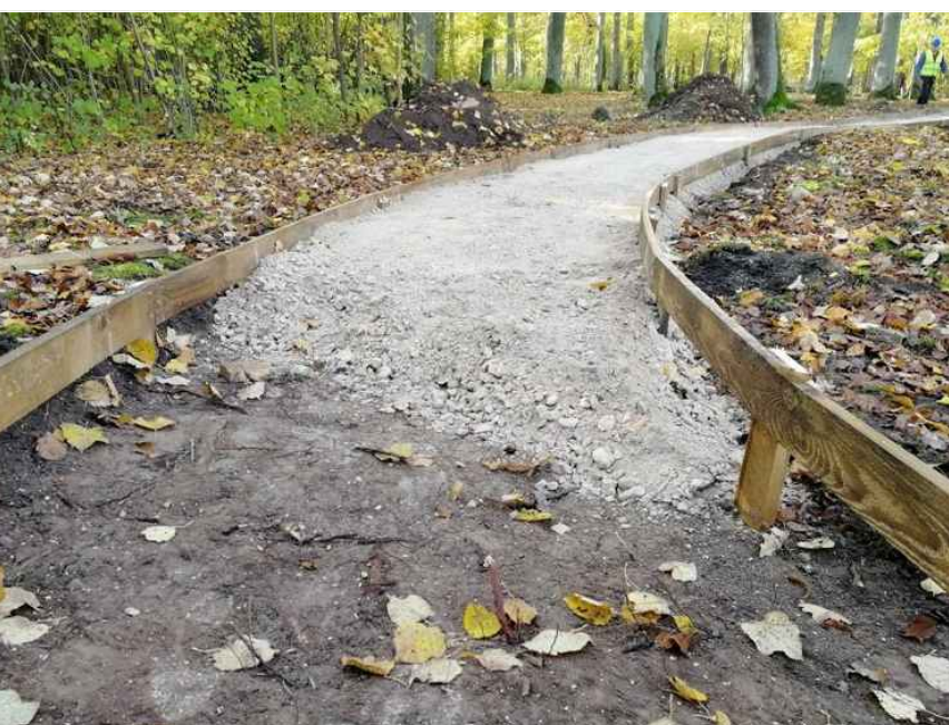
Grants celiņu izbūves process ar koka apmalēm Elejas muižas parkā
