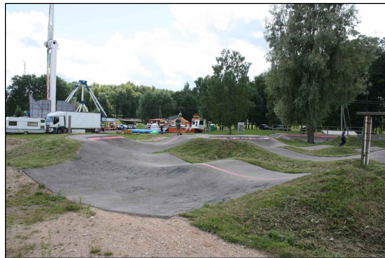
4 Asfalta seguma velo trase 'pump track'
