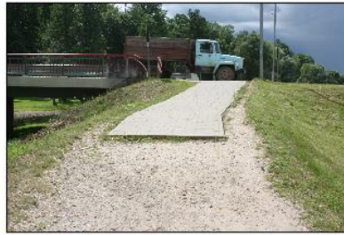
8 Betona bruģakmens seguma celiņš
