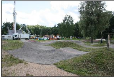
4 Asfalta seguma velo trase 'pump track'
