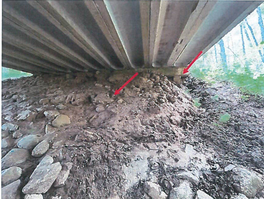
13.att. Trūkst konusa nostiprinājums, veidojas paskalojums uzbērumā. Skats uz krasta balstu Nr.4.
