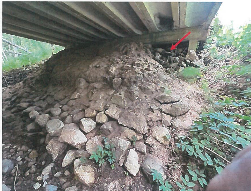
10.att. Trūkst konusa nostiprinājums, veidojas paskalojums uzbērumā. Skats uz krasta balstu Nr.1.
