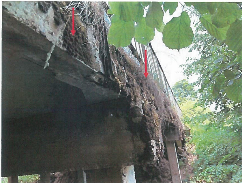
14.att. Apageums uz tilta fasādes. Skats lejteces pusē.
