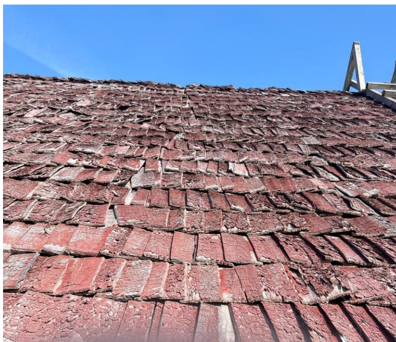
Griesti ar ūdens notecējumu atstātiem plankumiem
