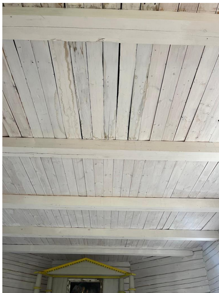
Griesti ar ūdens notecējumu atstātiem plankumiem
