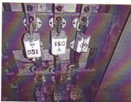
Daudzos skapjos drošinātājiem papildus uztīti vadi pretestības palielināšanai
