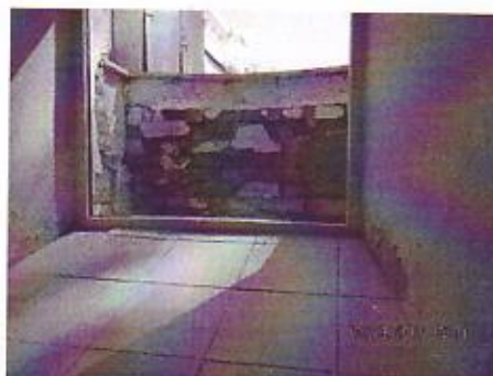
aiz logiem redzamas gaismas šahtu ķieģeļu sienas ar izskalotām šuvēm un sadēdējušiem ķieģeļiem
