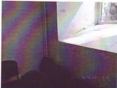
mitruma iespaidā bojāta siena un mūris, vizuāli novērojamas horizontālas deformācijas plaisas
