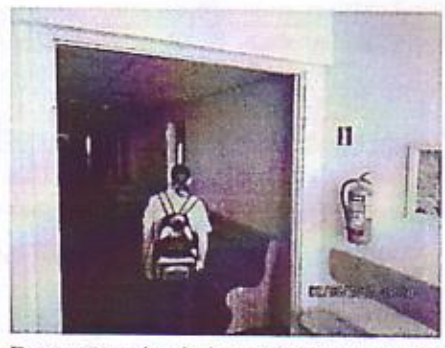
Demontētas durvis kas atdala ugunsdrošo nodalījumu - kāpņu telpu Nr.56 un Nr.70 no koridora
