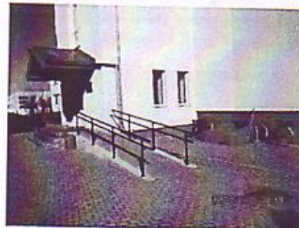
No fasādes puses izbūvēts lēzens panduss iekļūšanai skolas koridorā
