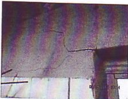
konstatēta slīpa deformācijas plaisa nesošajā sienā
