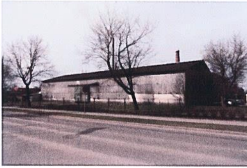
3.attēls.Iebrauktuve no Bērzpils ielas
