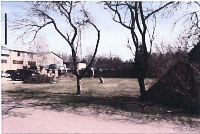
13. att. Jaunas katlu mājas būvniecības vieta (demontējamās, daļēji sagruvušās ēkas vietā)
