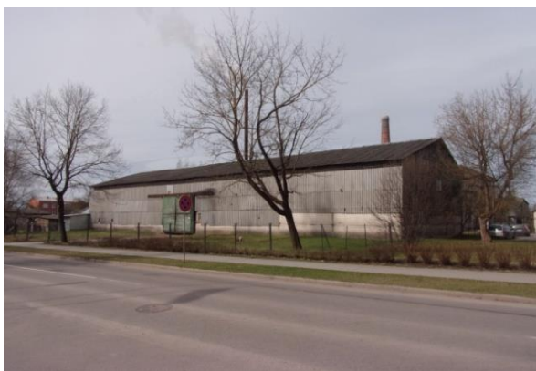
5.attēls. Iebrauktuve no Bērzpils ielas
