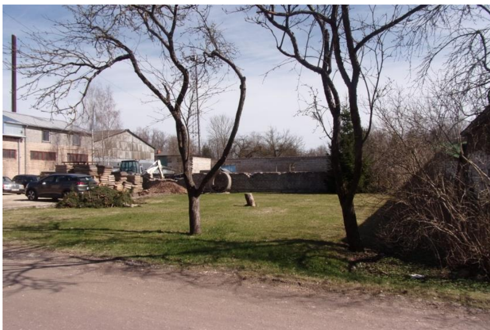
12. attēls. Jaunas katlu mājas būvniecības vieta (demontējamās, daļēji sagruvušās ēkas vietā), V. Baškirova foto, 2018.g.
